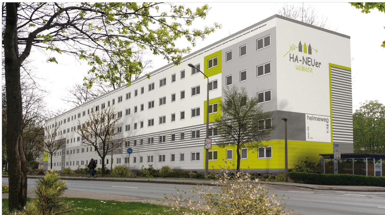
Erst simulierte Sven Weber die neue Fassadengestaltung am Computer. Dann wurde sie in die Tat umgesetzt.
